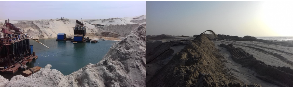
Photo 37 : Fosses d'exploitation avec drague et usine de concentration humide (site minier MTR) à droite
