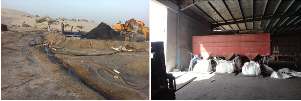
Photo 39 : Récupération du minéral concentré dans le bassin de décantation à droite
